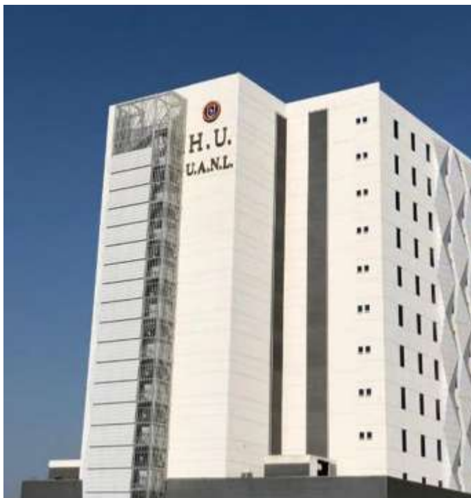
Figura 6. Antiguo Hospital Civil.
