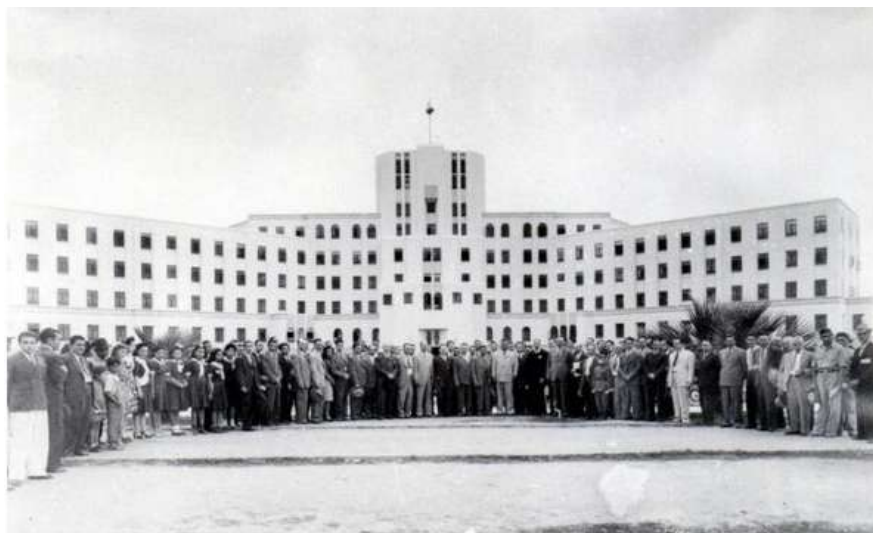
Figura 4. Antiguo Hospital Civil.
