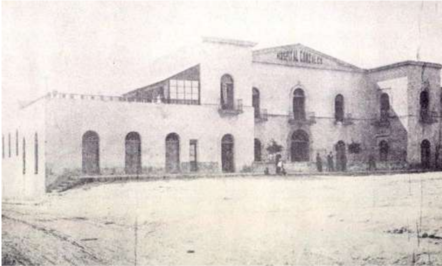
Figura 3. Antiguo Hospital Civil.
